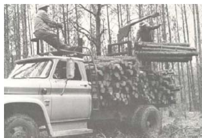
“Bobtail” equipado com carregador “big stick” (24)
